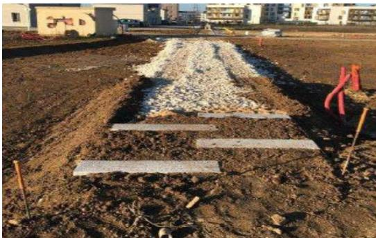
Figure 19: Travaux d'essai des pas japonais.
